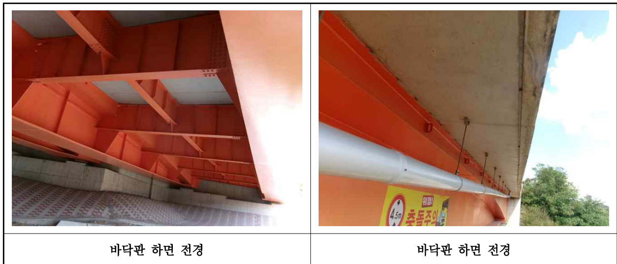
【사진 18.3.25】 바닥판하면 전경
