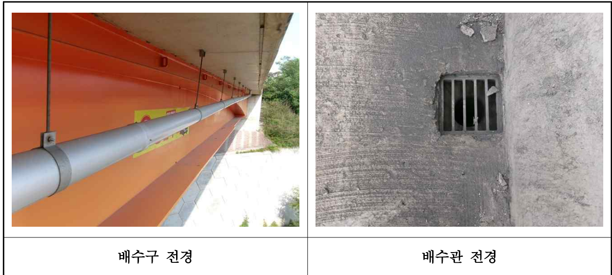
【사진 18.3.41】 배수시설 전경
