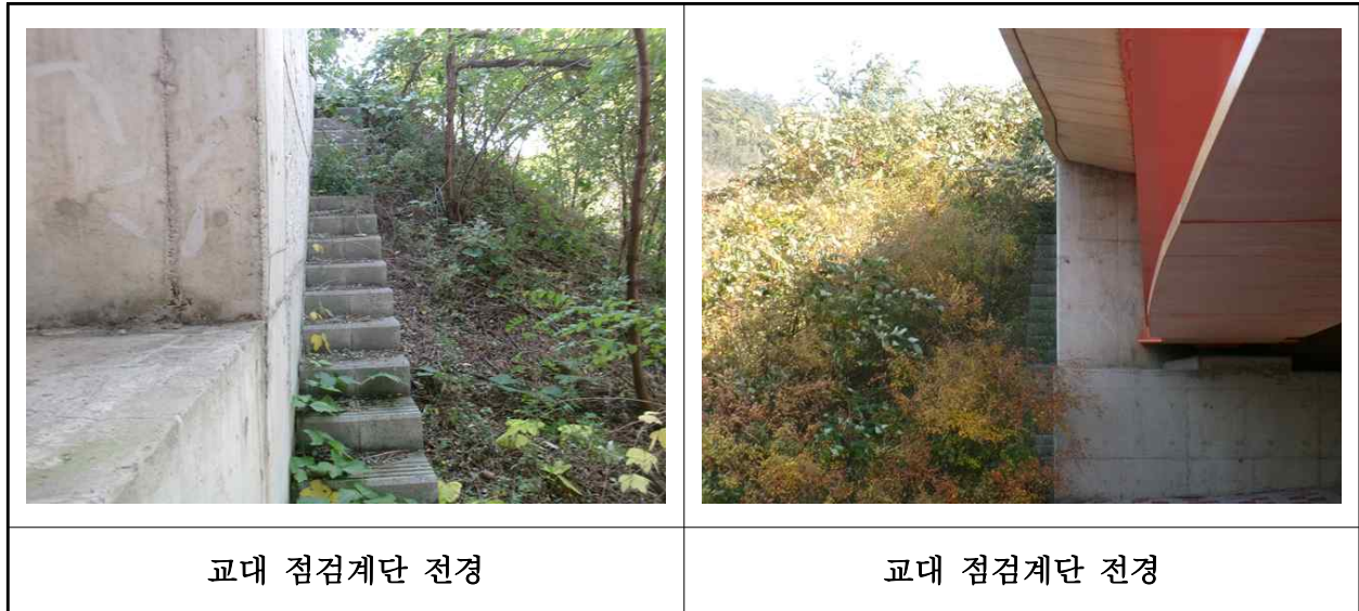
【사진 18.3.23】 교량 점검시설 전경
