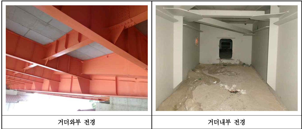
【사진 18.3.4】 거더 전경
