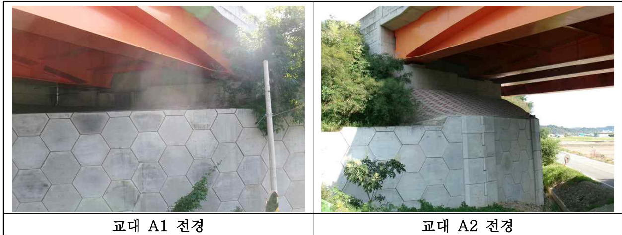
【사진 18.3.8】 교대 전경
