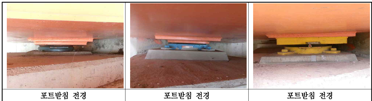
【사진 18.3.32】 교량받침 전경
