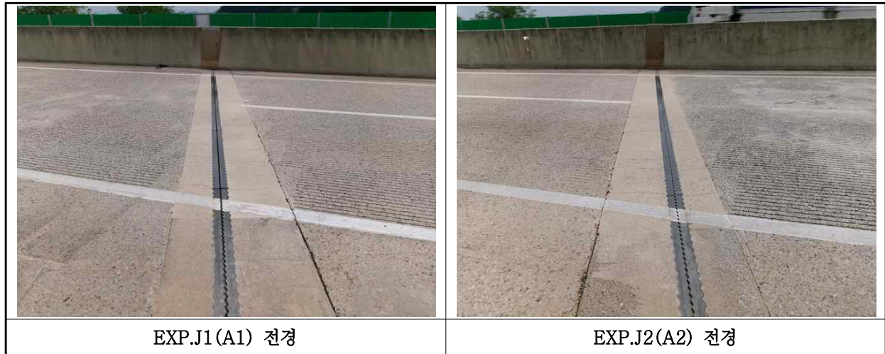
【사진 18.3.14】 신축이음장치 전경
