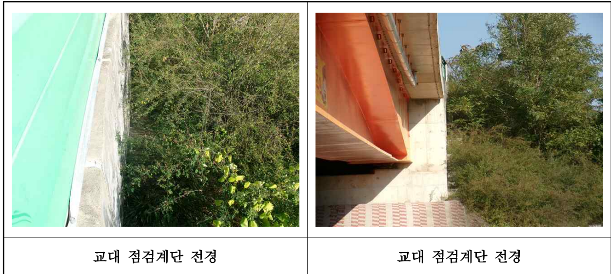
【사진 18.3.45】 교량 점검시설 전경
