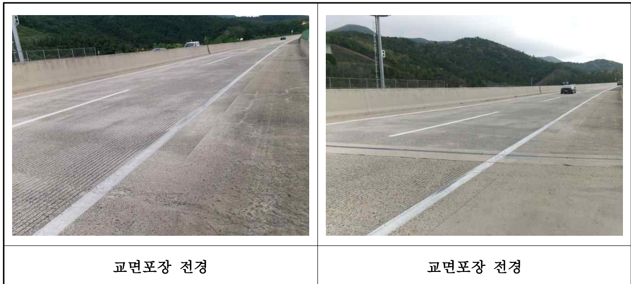
【사진 18.3.39】 교면포장 전경
