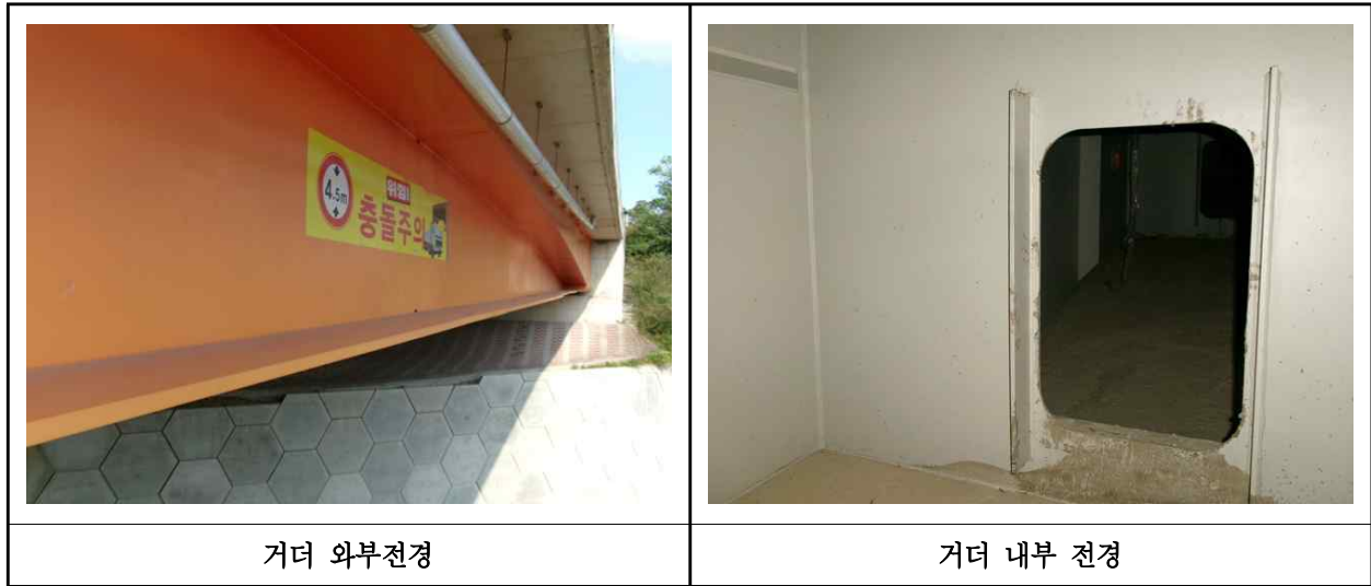
【사진 18.3.26】 거더 전경
