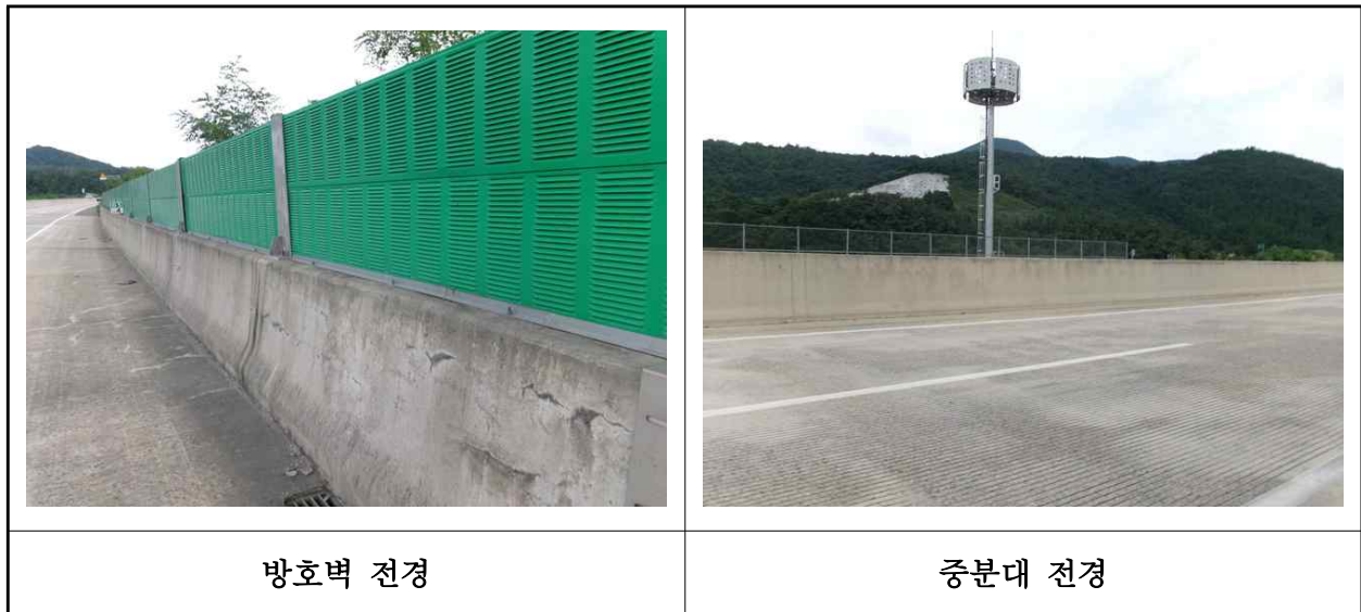
【사진 18.3.43】 방호벽 및 중앙분리대 전경
