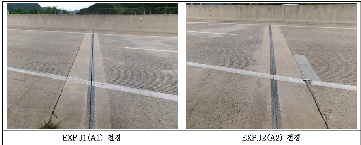
【사진 18.3.36】 신축이음장치 전경
