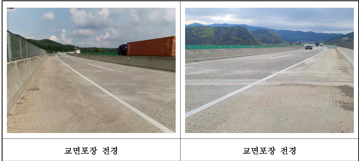
【사진 18.3.17】 교면포장 전경
